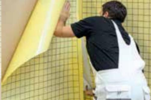
**Ohne Wasser – ideal auch zur Verlegung auf Gips- und Mineralputzen und im Trockenbau. Erst die Ecken, dann die Bahn - fixieren - Schutzfolie abziehen - andrücken - Fliesen drauf – fertig!**
