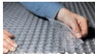
Pose de la natte de drainage DURABASE DD 80++ avec chevauchement
