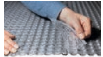
Colocación de la estera de drenaje doble DURABASE DD 80++ con solapamiento
